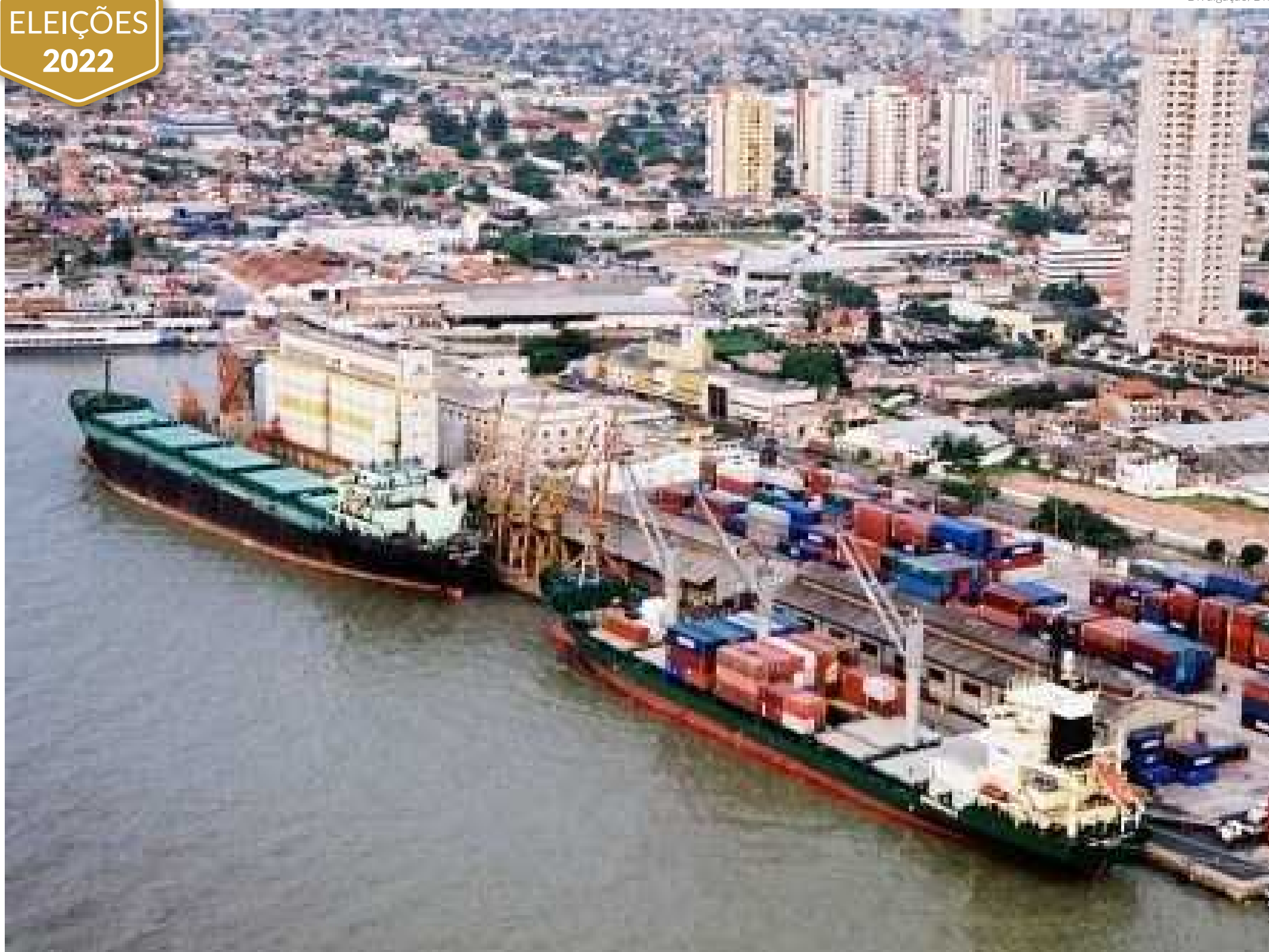
O Pará conta com três portos públicos: Vila do Conde, Belém e Santarém. Os três contam com acessos rodoviários e fluvio-marítimo
